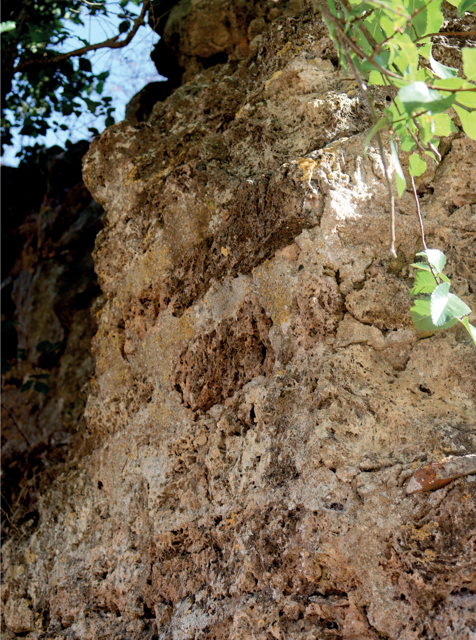
FIG. 28. Pormenor de arranque de arco de edificio anexo
