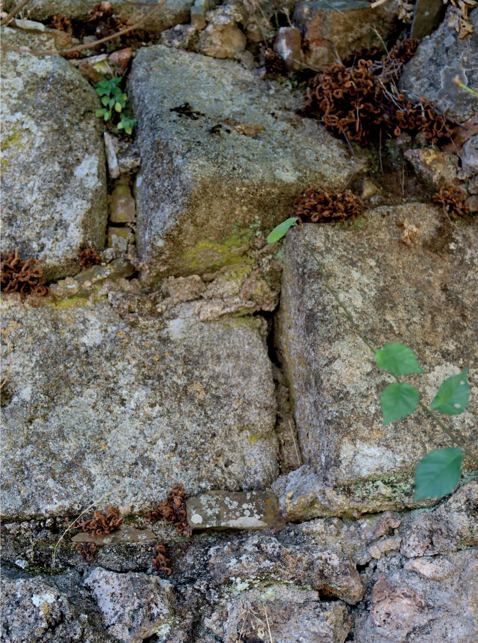
FIG. 36. integración de la obra de sillares con la mampostería lateral
