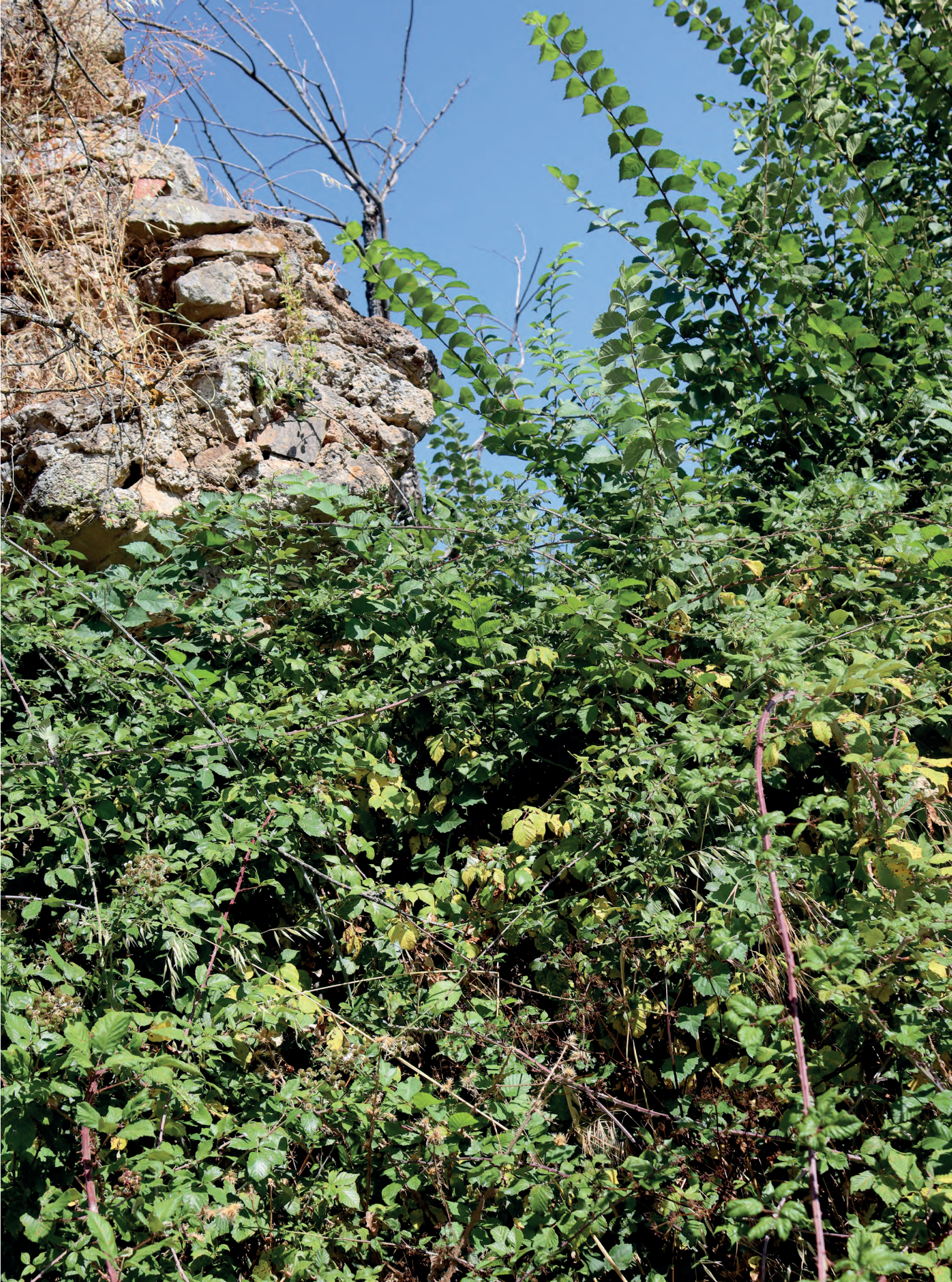
FIG. 29. Vista lateral del inicio de arco de edificio anexo
