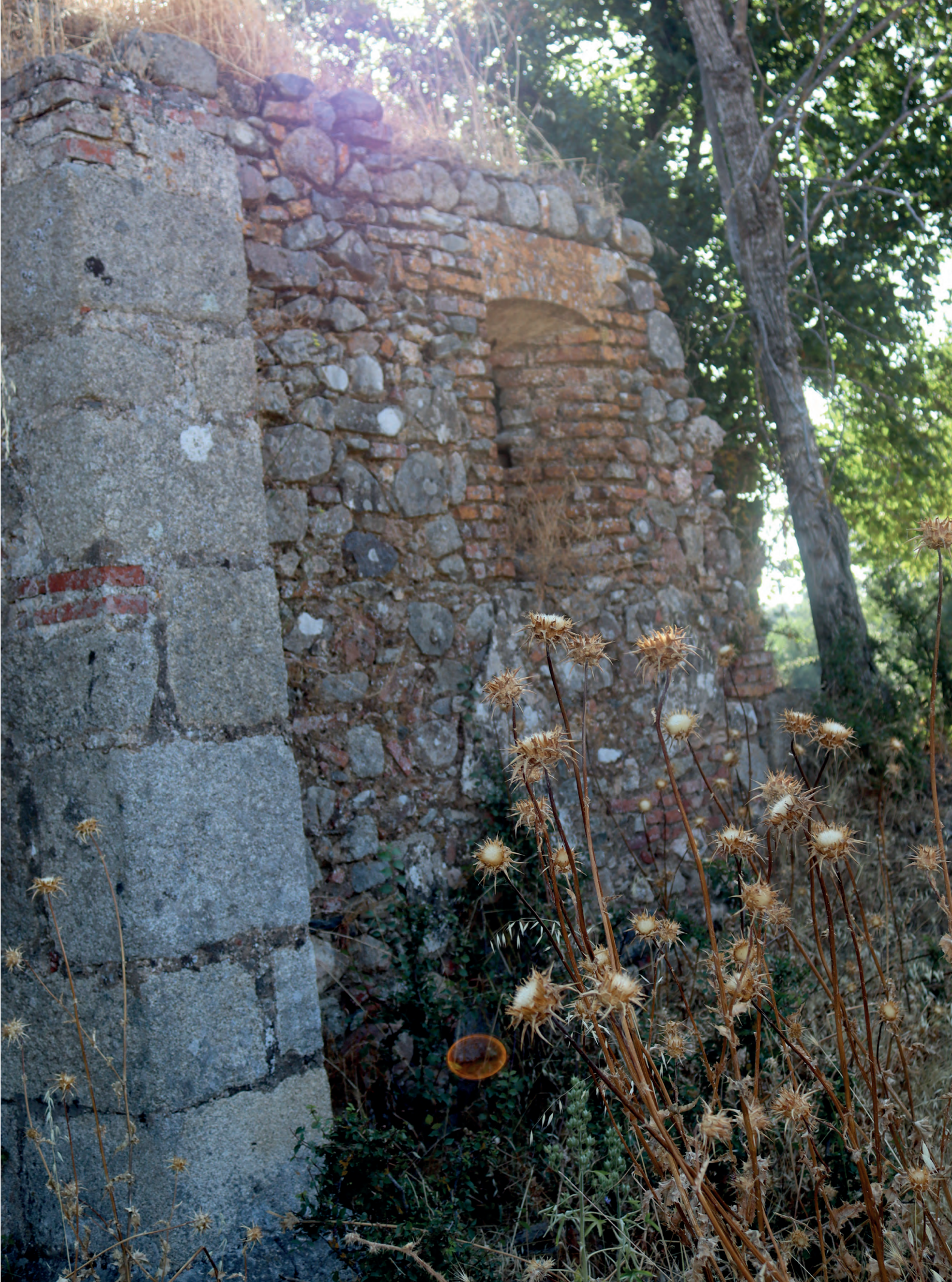
FIG. 44. Vista de los pilares contrafuertes del muro de carga principal
