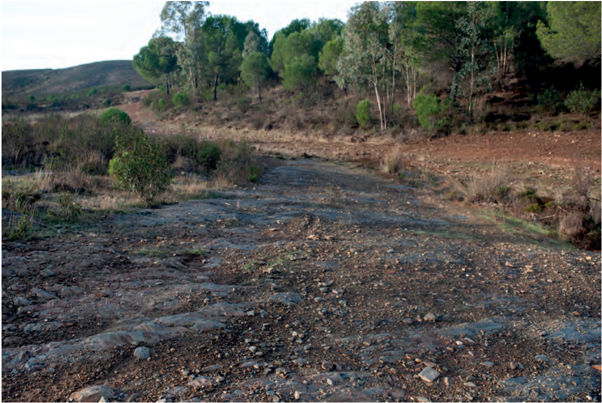
FIG. 78. Estado actual de la calzada romana hacia Mérida en las afueras del municipio de Valverde del Camino (Huelva).
