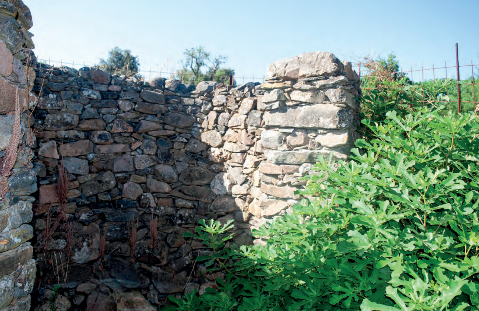
FIG. 62. Construcción circular de mampostería de granito y material de aluvión en el manantial cercano al edificio principal
