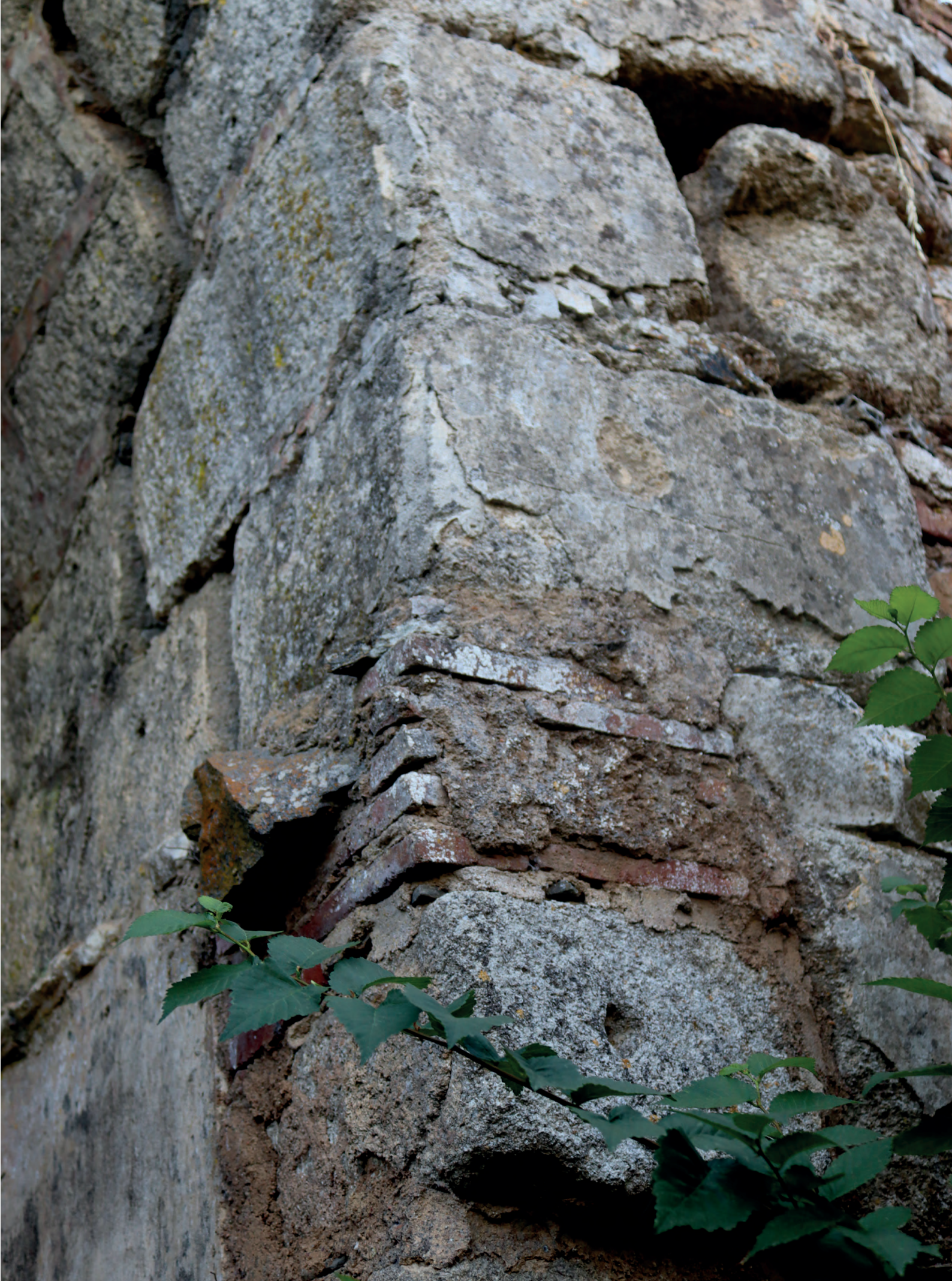
FIG. 13. Sillería de granito del arranque de la bóveda
