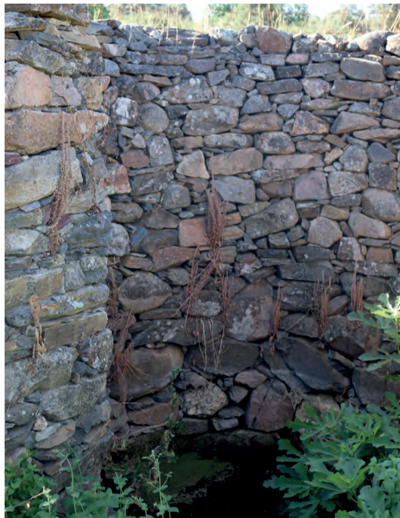
FIG. 64. Detalle del muro del manantial
