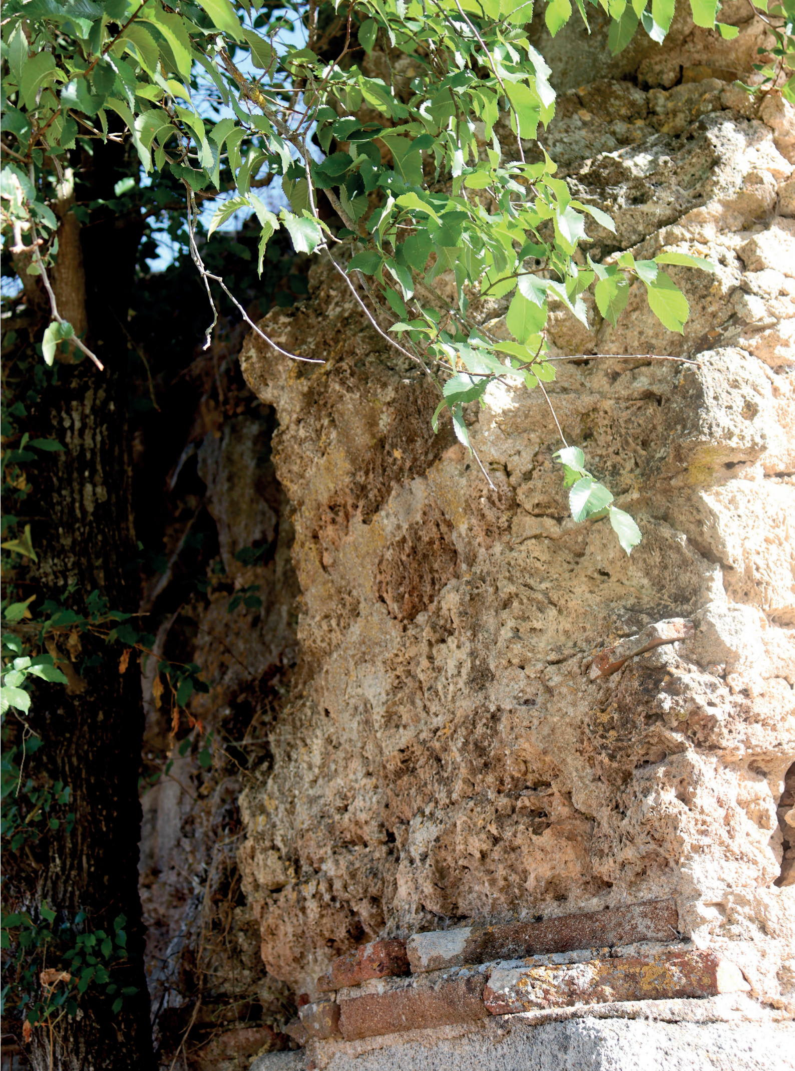
FIG. 27. Arranque de arco de edificio anexo
