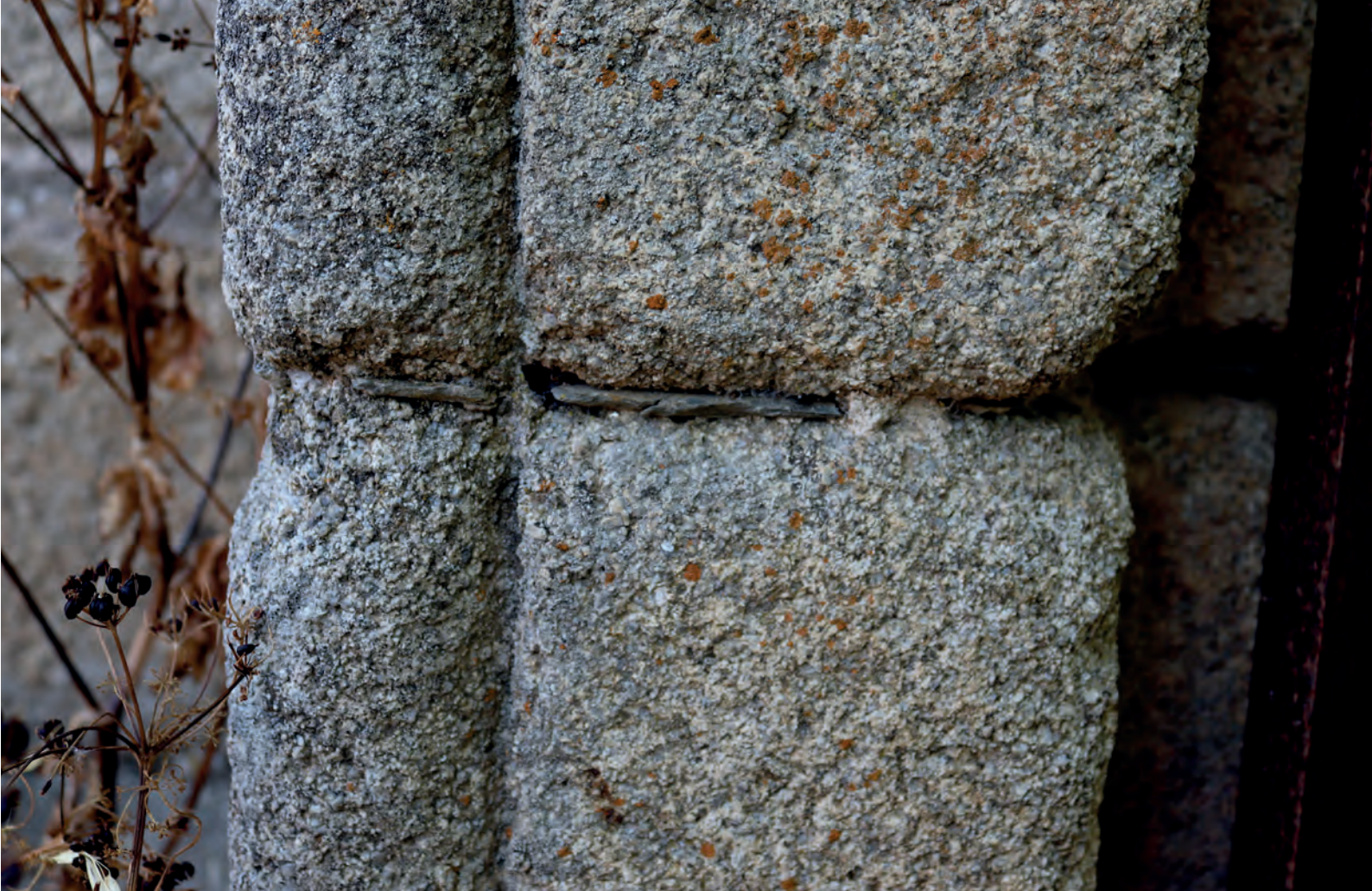
FIG. 50. Pormenor del interior del almohadillado de plomo de los pilares del muro lateral
