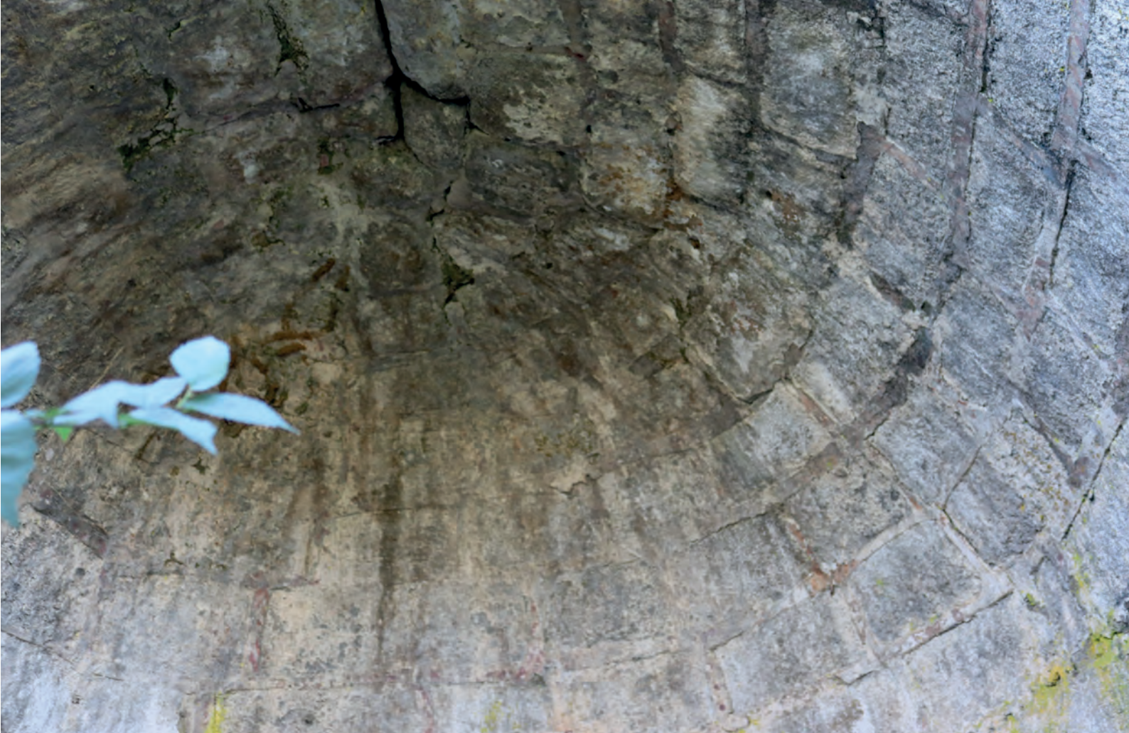
FIG. 7. Detalle de construcción de la obra de la bóveda visigoda
