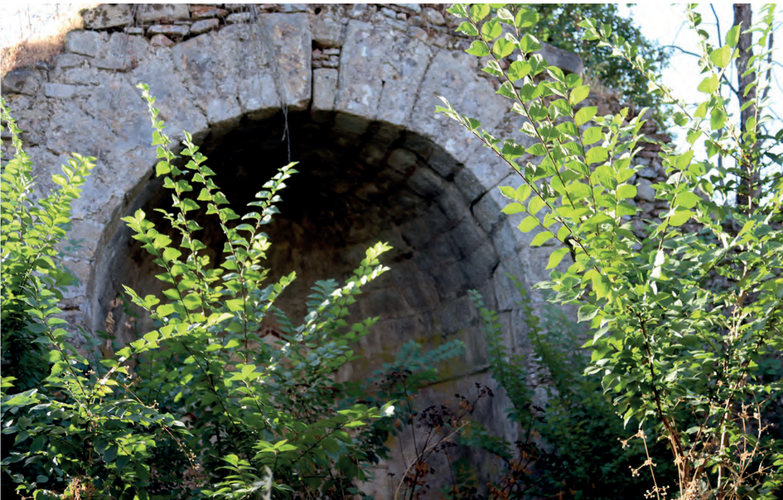
FIG. 6. Vista general de la bóveda visigoda
