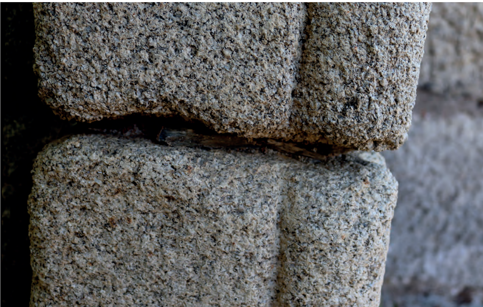
FIG. 49. Detalle del almohadillado de plomo entre sillares de granito de los pilares laterales
