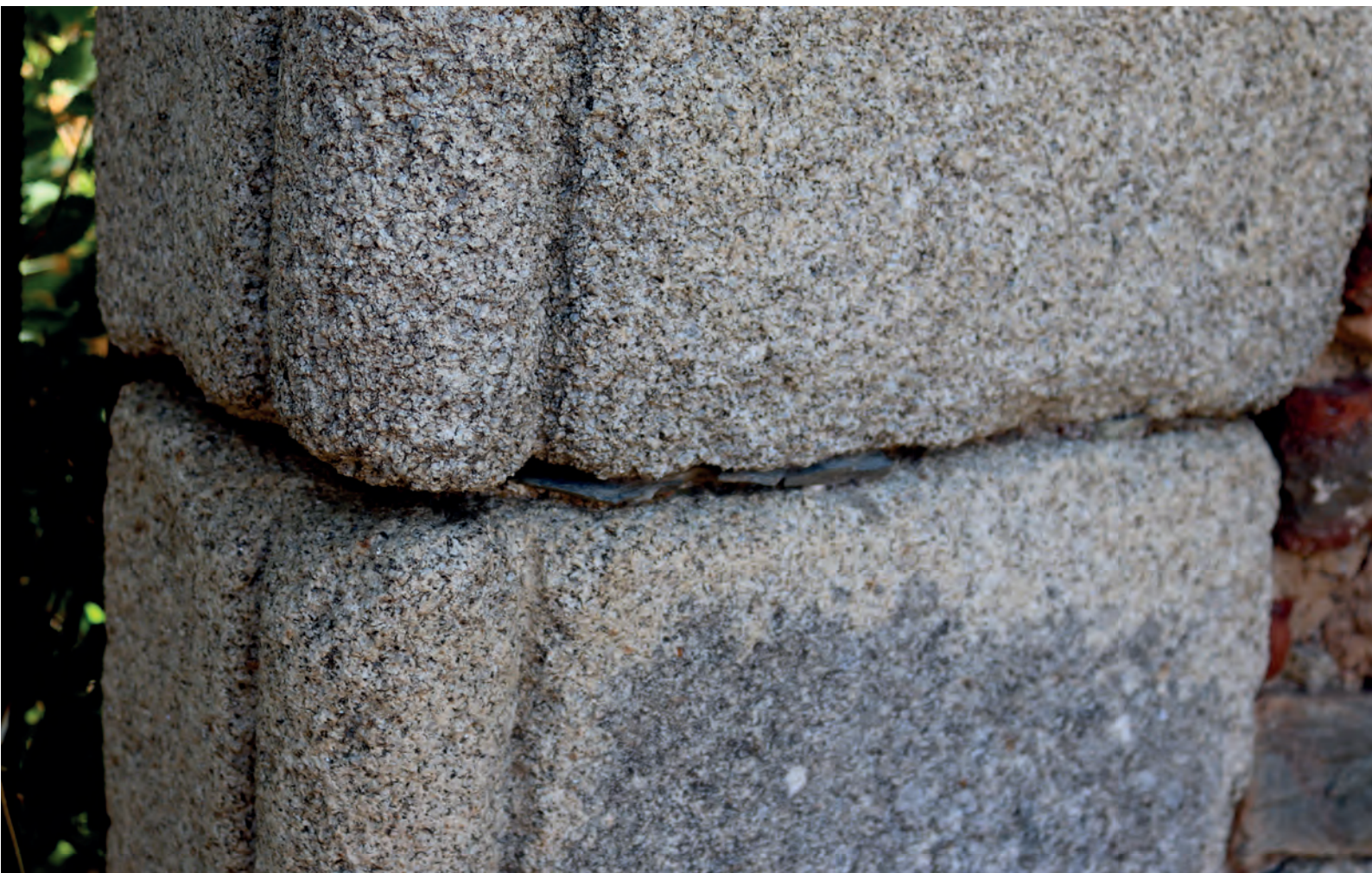
FIG. 51. Almohadillado de plomo de los sillares de granito
