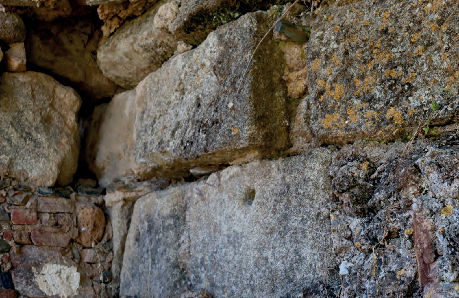
FIG. 37. Pormenor de la obra de labrado de los sillares de granito
