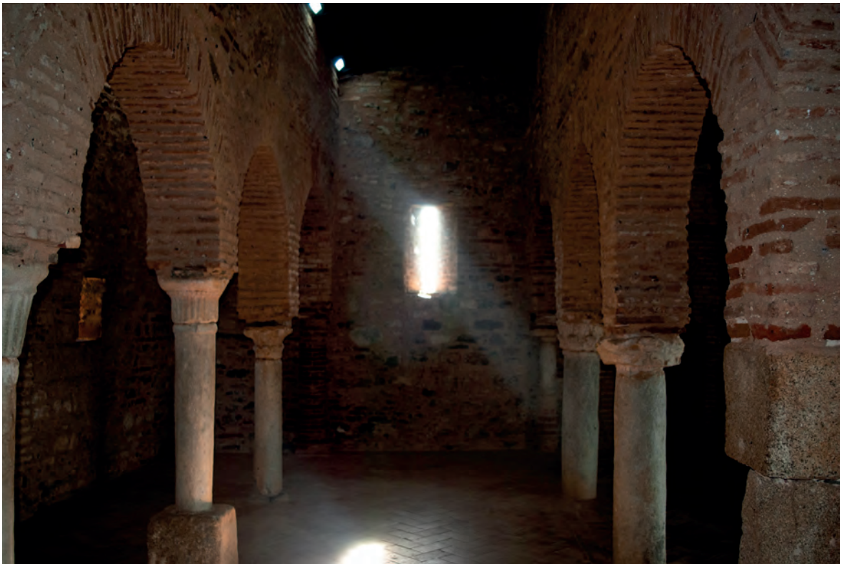
FIG. 8. Detalle del interior de la mezquita de Almonaster la Real, Huelva.
