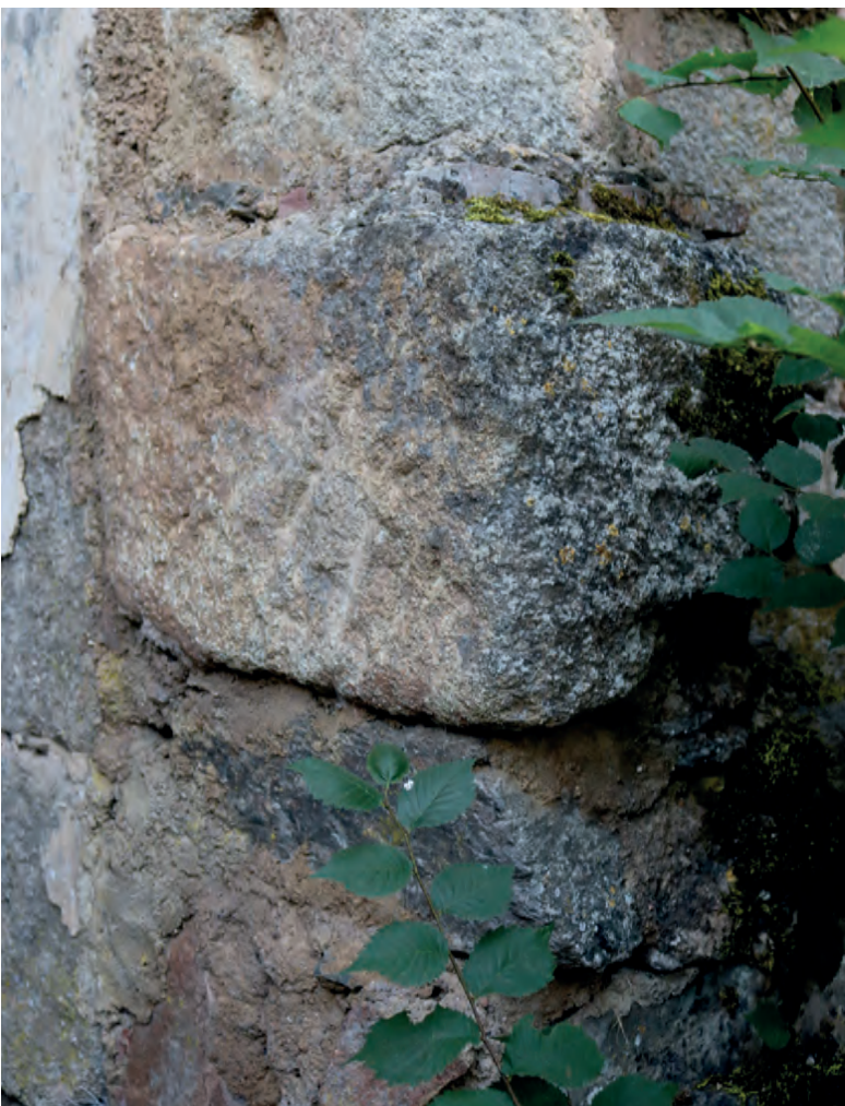
FIG. 33. Pormenor del trabajo de colocación de los sillares de granito
