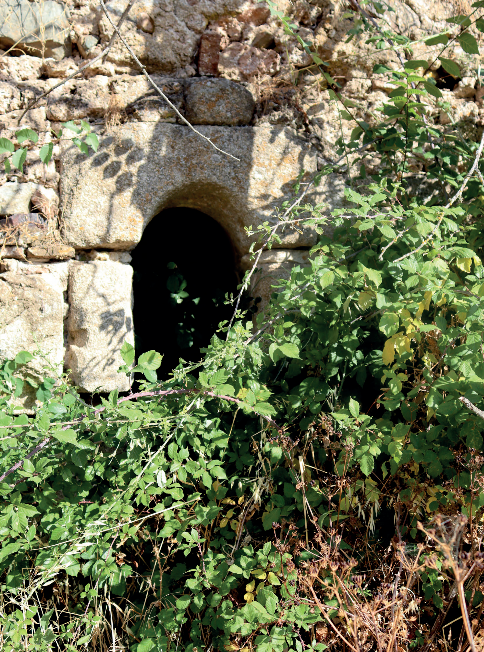
FIG. 21. Pormenor del vano de falso arco de granito de la cabecera del edificio
