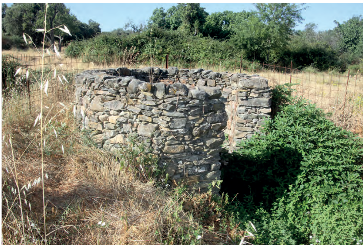
FIG. 128. Boca de aguada sita en el conjunto monacal de San Miguel de los Fresnos.
