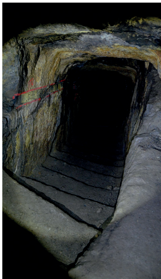
FIG. 86. Galería de la mina romana de Tresminas, Vila Pouca de Aguiar, Portugal.
