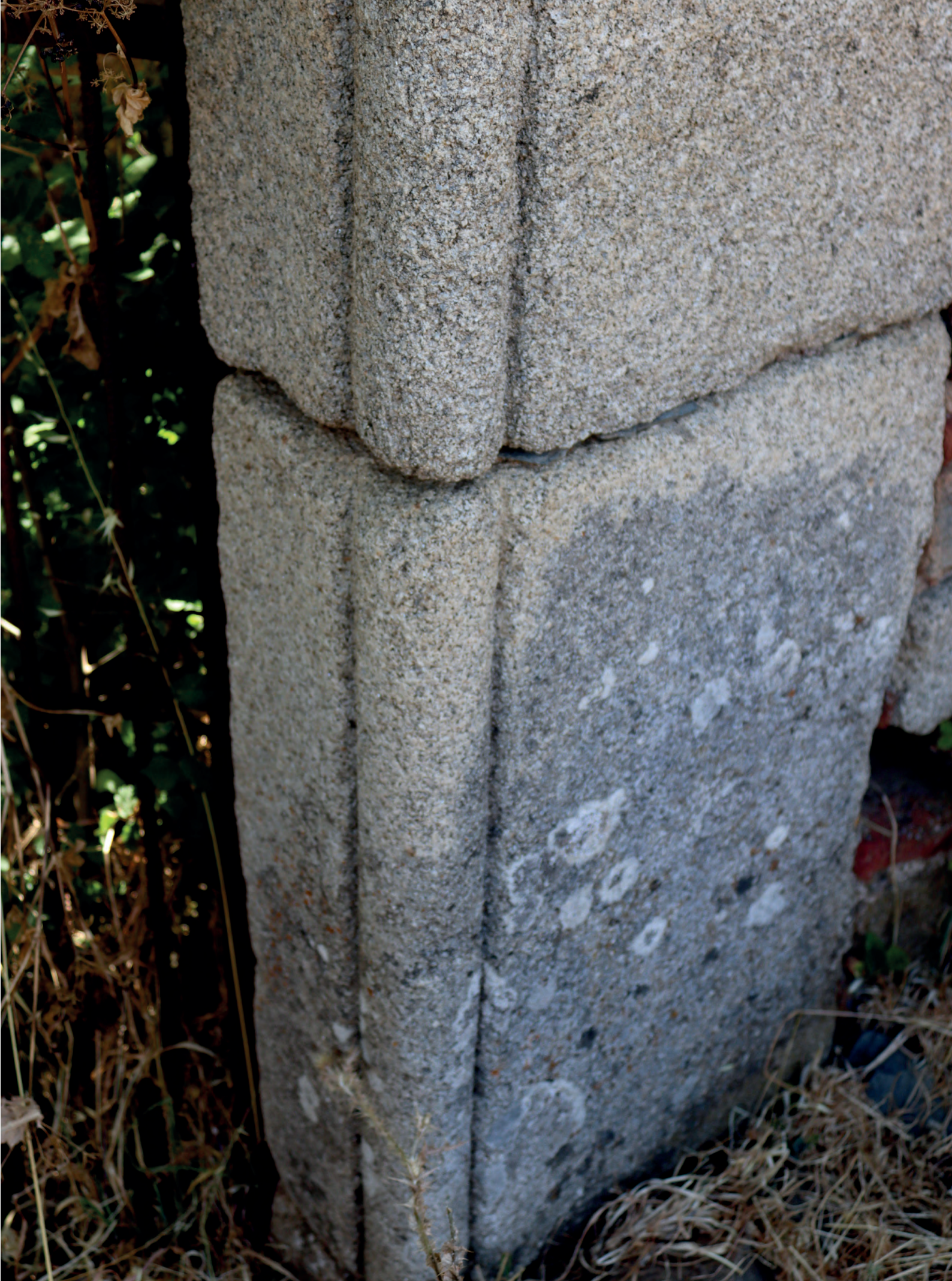
FIG. 47. Detalle del trabajo de labrado de los pilares de granito de la puerta del muro lateral
