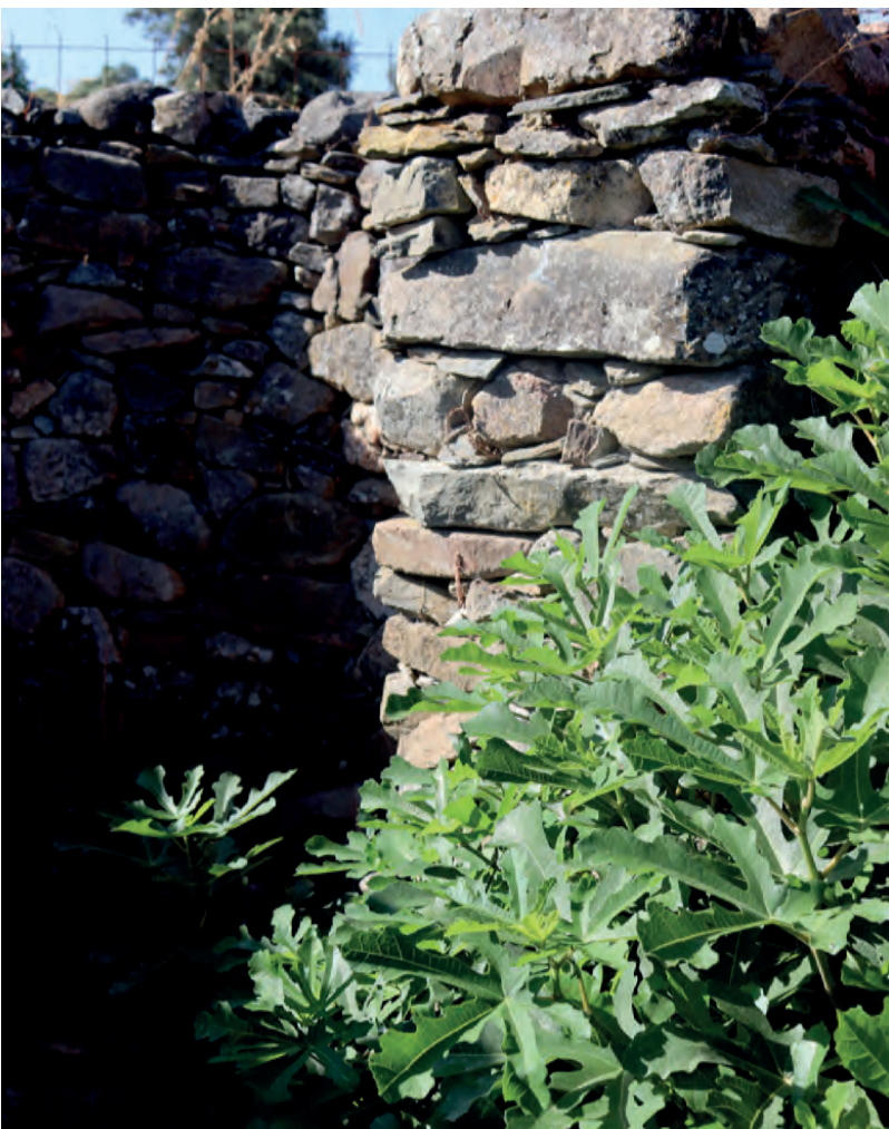
FIG. 63. Pormenor de la construcción protectora del manantial
