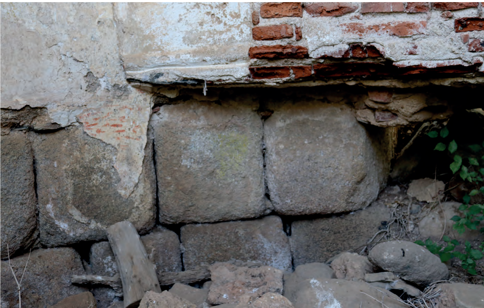
FIG. 16. Detalle de la sillería de granito del zócalo de la bóveda, parte central
