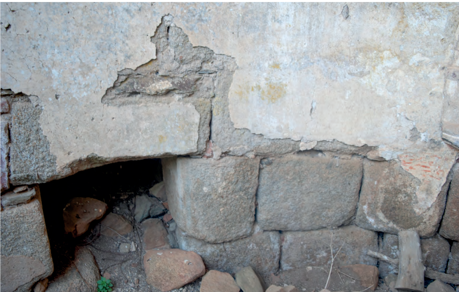
FIG. 18. Pormenor de la aperturas de andito en la sillería de granito en el ala izquierda del edificio
