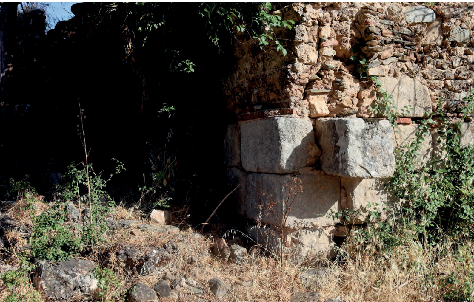
FIG. 26. Vista de los arranque de arco de edificios anexos en el muro
