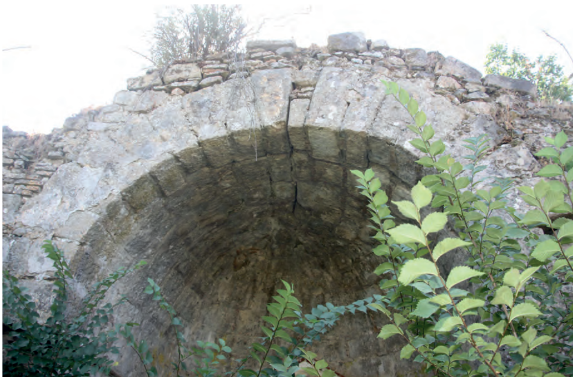
FIG. 111. Bóveda de sillería de la nave de San Miguel de los Fresnos.
