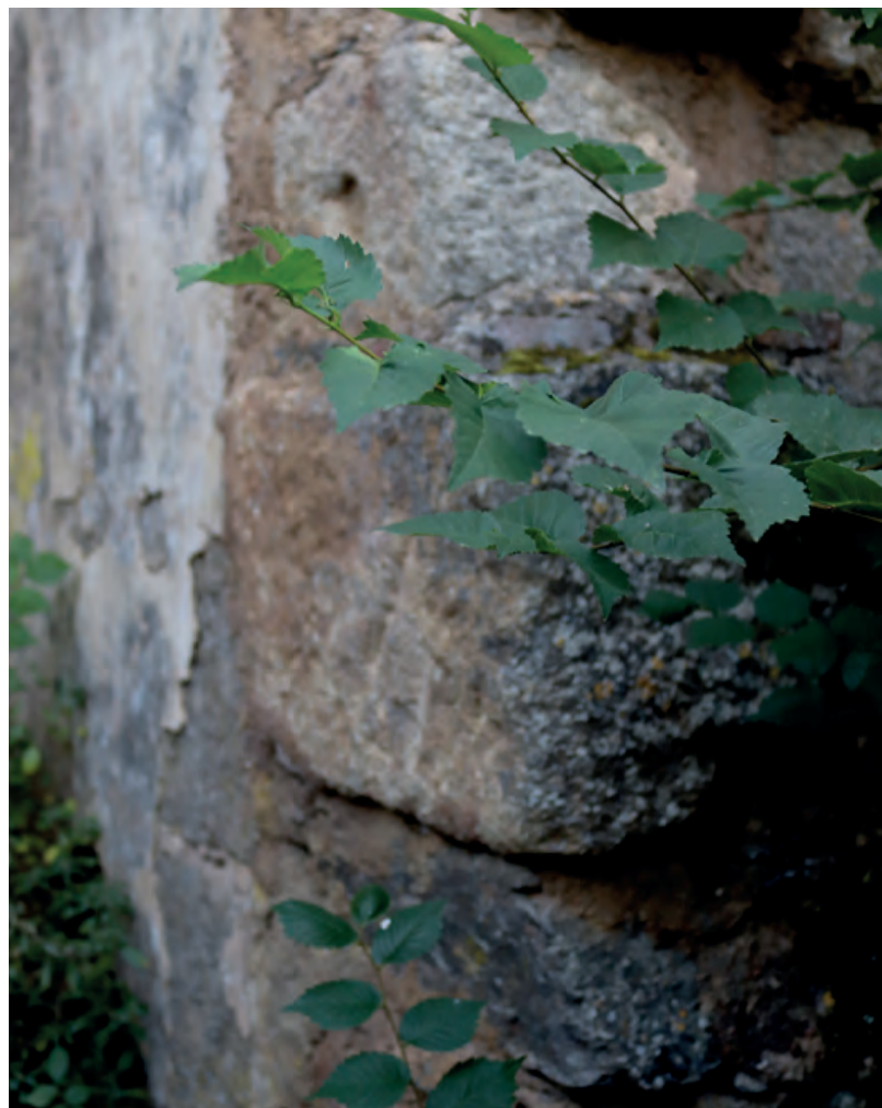
FIG. 34. Vista en detalle de la superposición de sillares de granito en la obra interior
