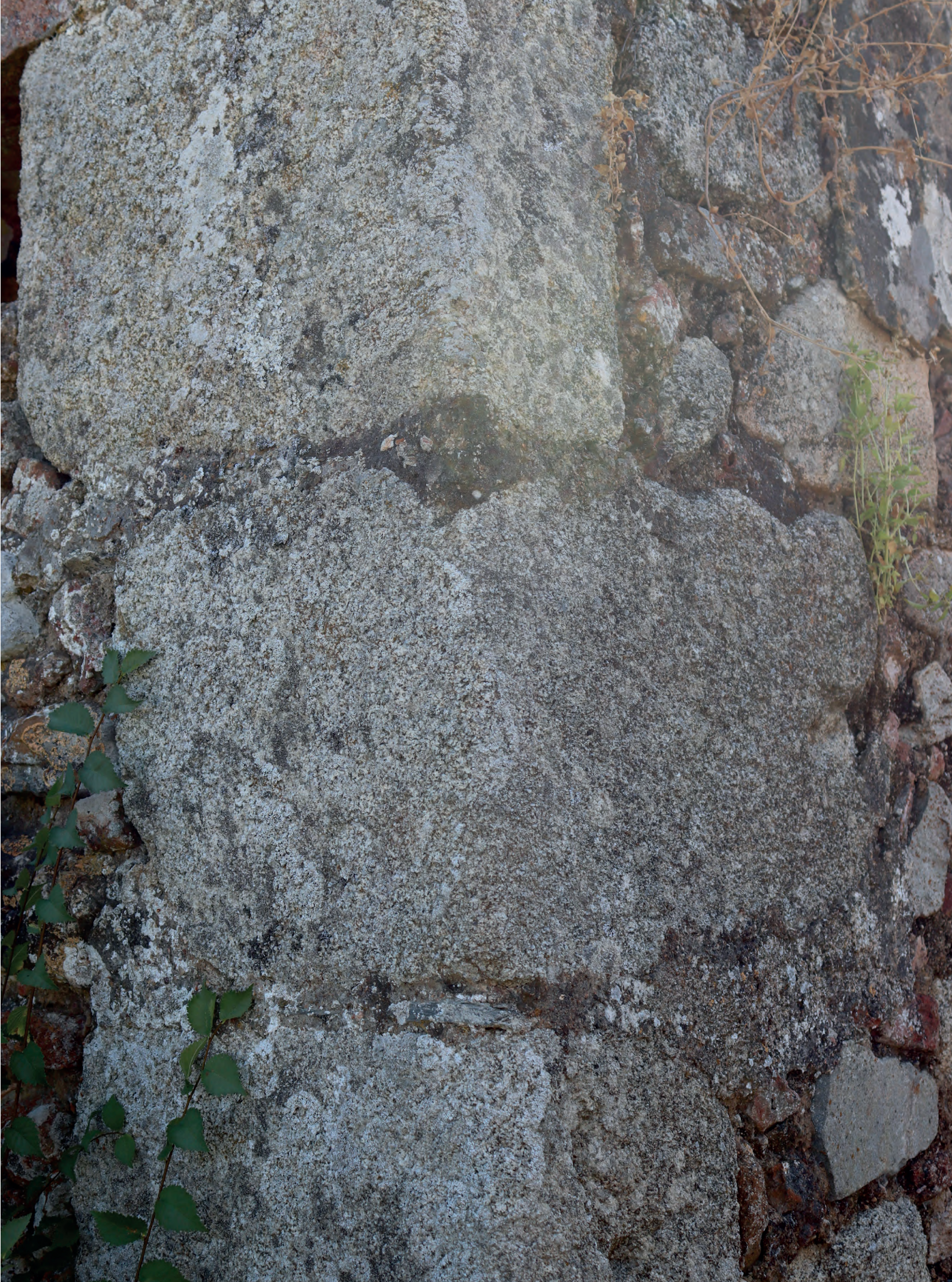
FIG. 46. Pormenor de los detalles de trabajo de los sillares de granito de los zócalos angulares de los muros de carga
