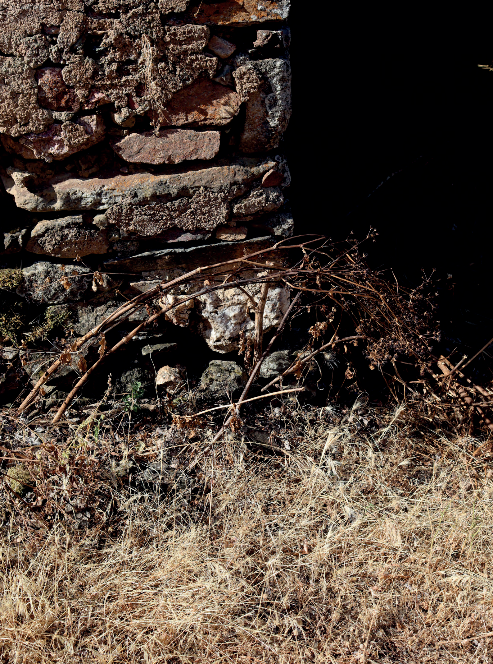
FIG. 57. Pormenor de la construcción en mampostería de los edificios anexos
