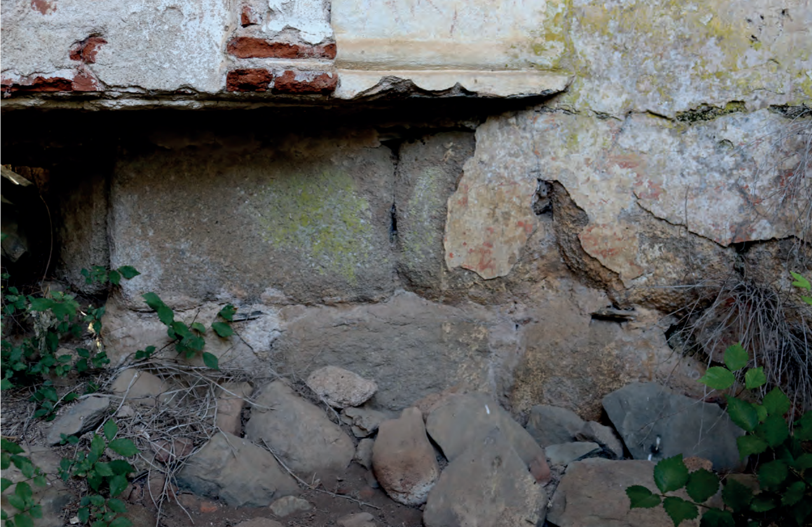
FIG. 15. Detalle de la labor del zócalo de granito de la cabecera del edificio
