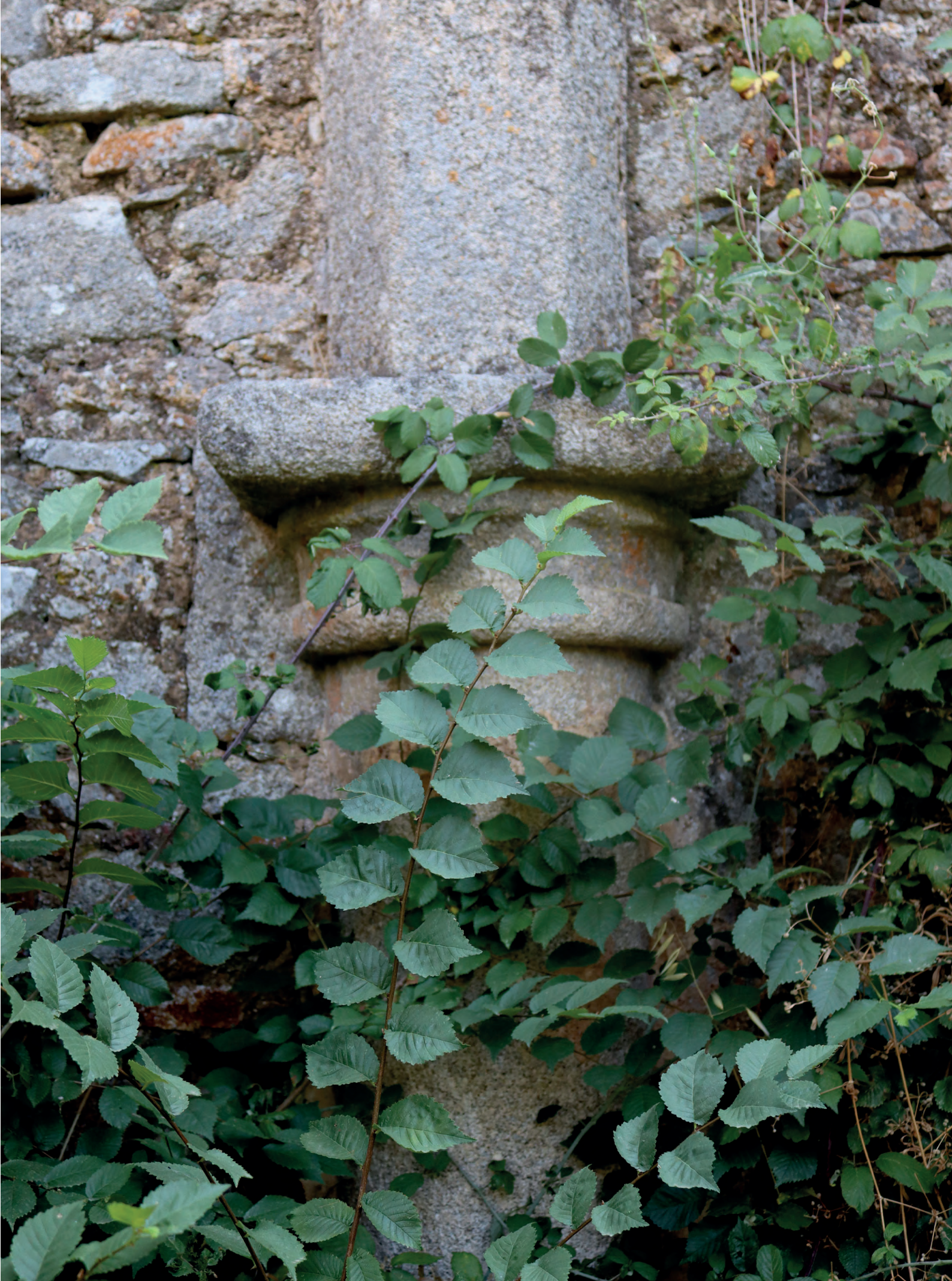
FIG. 41. Detalle de los trabajos de labrado de los capiteles de los pilares de apoyo de los arcos
