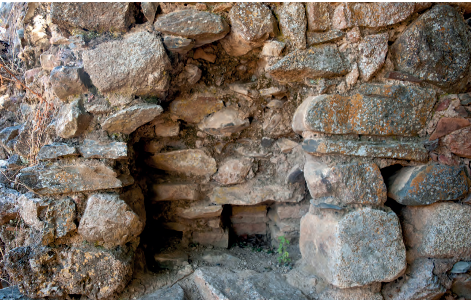
FIG. 38. Detalle de la obra de doble mampostería de los muros de soporte
