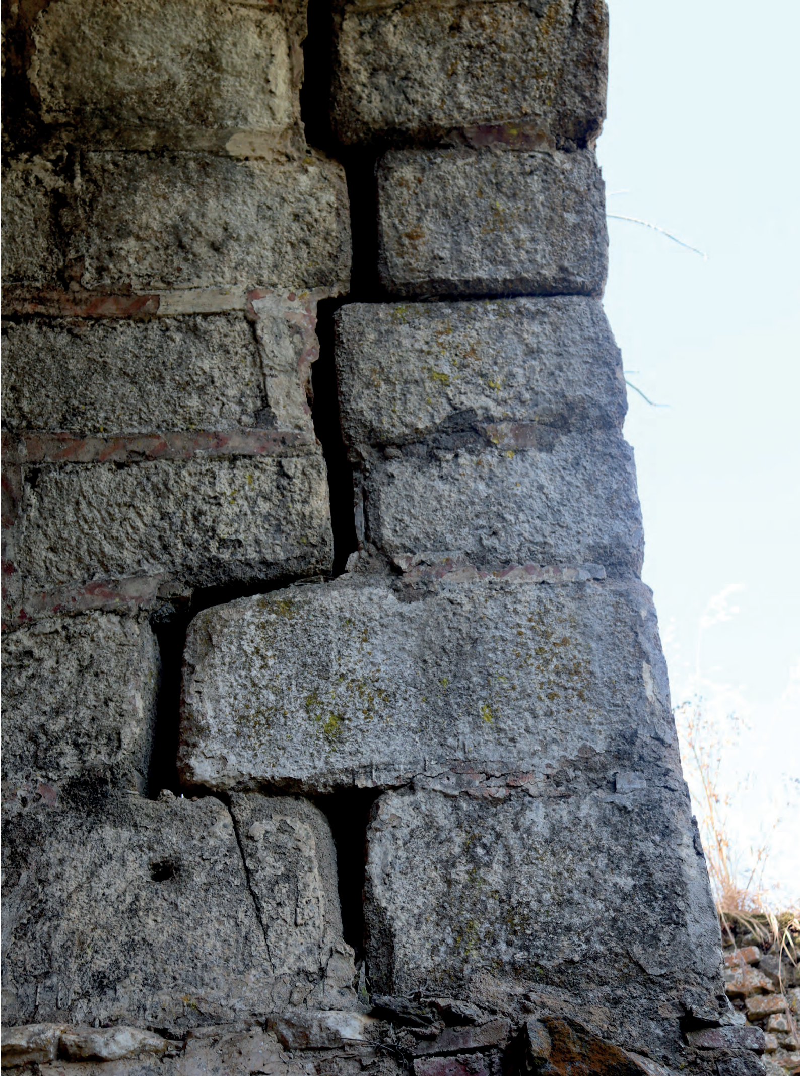
FIG. 10. Detalle de la situación actual de la sillería de la bóveda visigoda.
