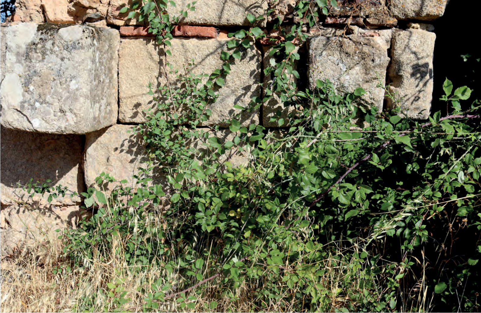
FIG. 24. Detalle de la sillería de granito del zócalo del edificio, muro de la cabecera
