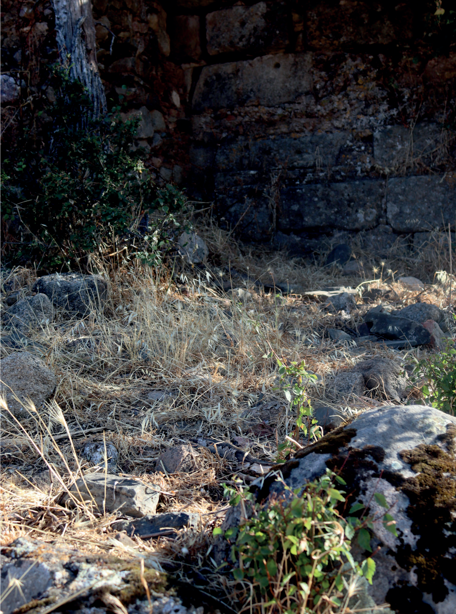
FIG. 52. Vista del material de derribo acumulado en el entorno del edificio
