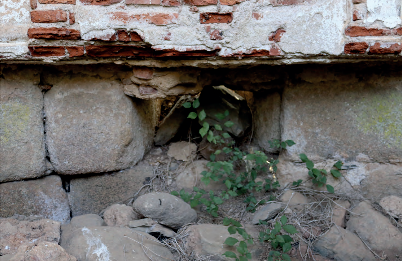
FIG. 17. Pormenor del estado y construcción del falso arco con labor de granito
