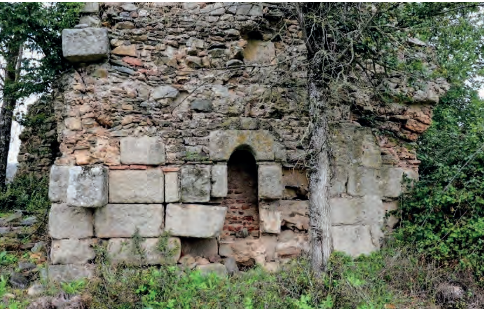
FIG. 20. Vista del muro exterior de la bóveda en la cabecera con vano visigodo de falso arco
