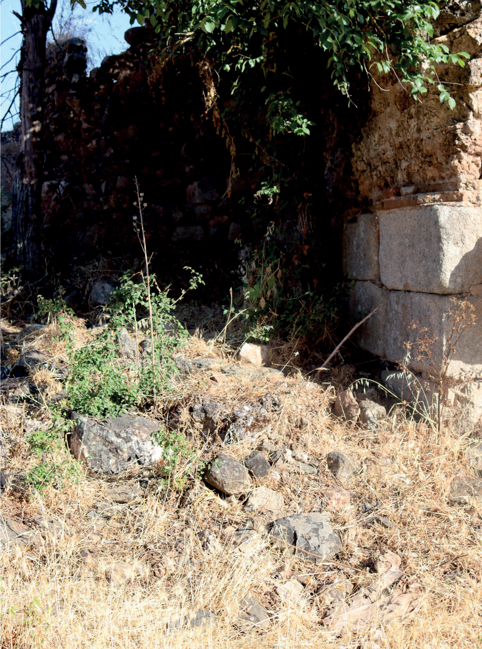
FIG. 25. Vista general de los arranques de arco de los edificios anexos a la cabecera
