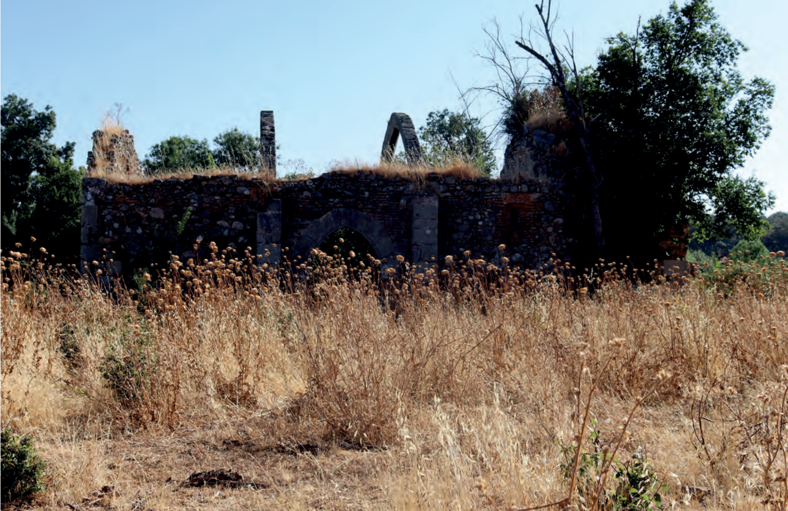
FIG. 1. Vista general del edificio principal
