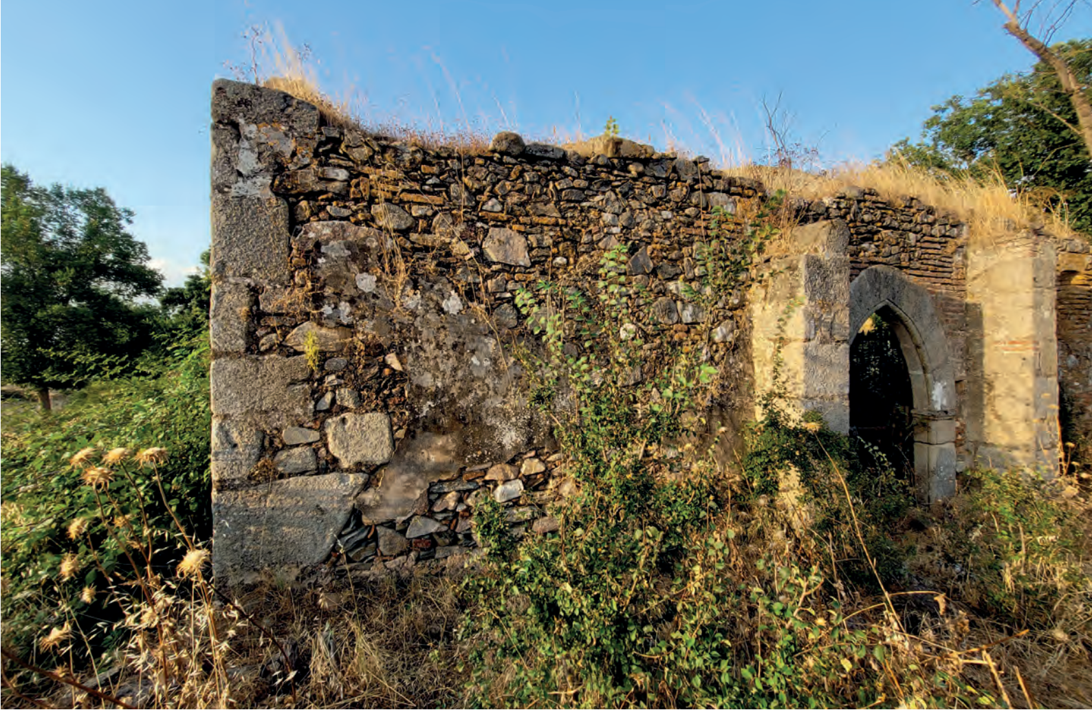
FIG. 4. Vista general de construcción con el zócalo en ángulo de granito
