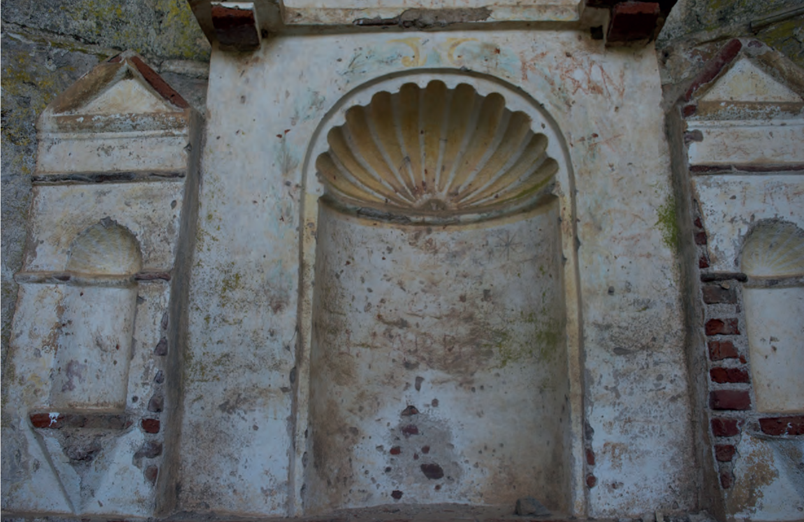
FIG. 19. Vista del estado actual del muro visigodo de la bóveda en la cabecera con la inserción de altar de obra en estilo renacentista
