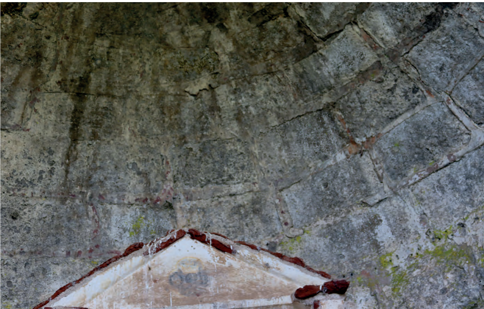
FIG. 9. Detalle de la sillería de la bóveda visigoda
