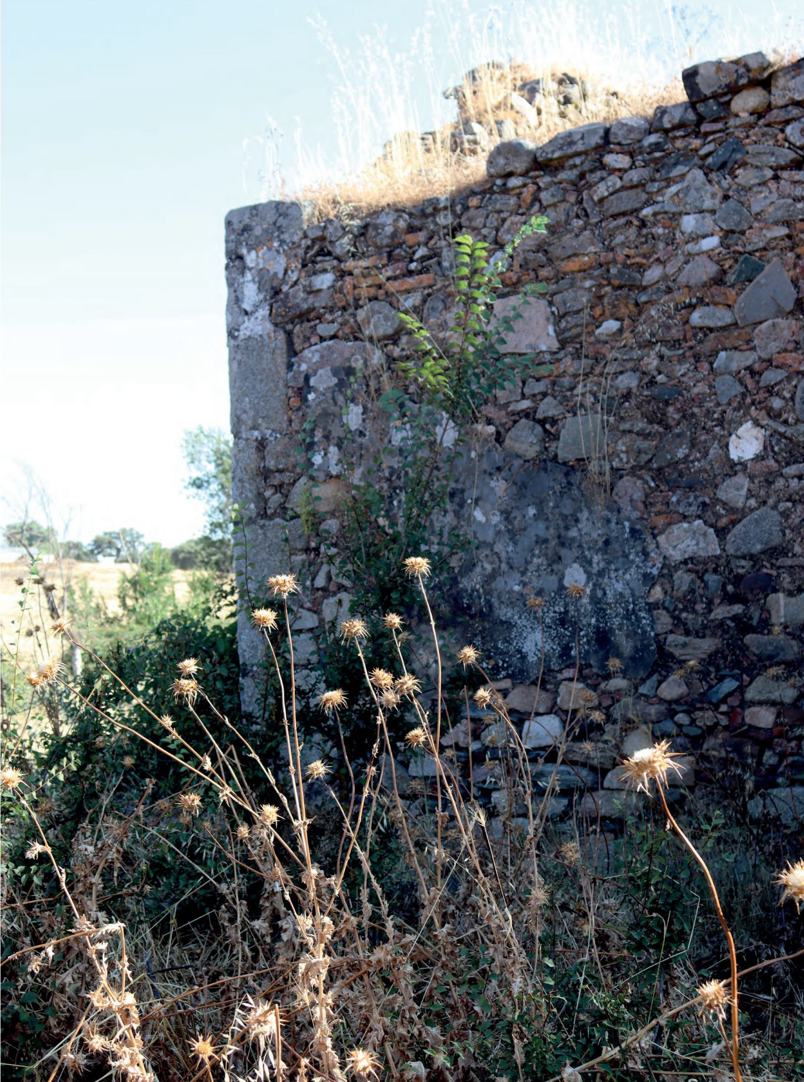
FIG. 45. Vista de los zócalos laterales en ángulo de los muros de carga principales
